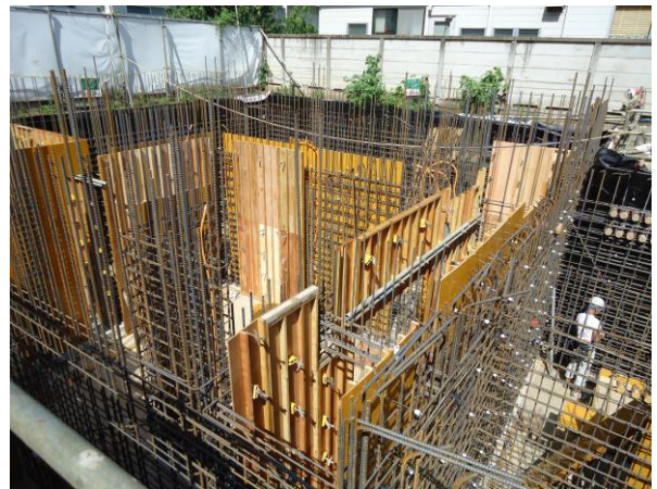
写真4：現場実習終盤状況
