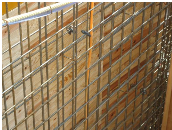
写真 2: 型枠製作(杉板付け)
