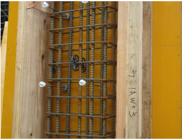
写真 3：サッシを入れるために型枠の内側に木を入れ段差を作る。
