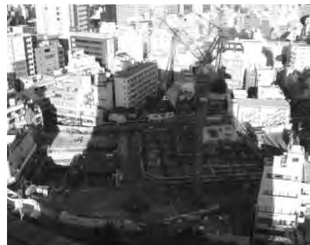
写真2 工事現場全景写真
