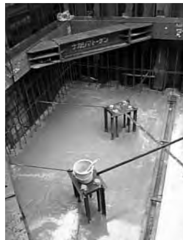
写真1 コンクリート打設後
